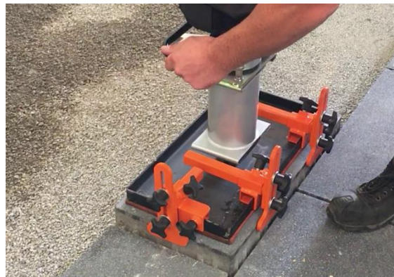
Bild 2: Beispiel für Vakuumverlegetechnik mit Anschlag (Fugenabstandhilfe) [Foto: Optimas]
