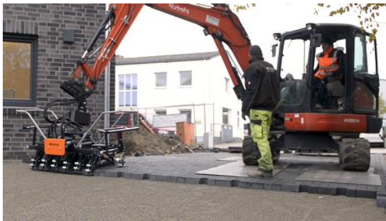
Bild 13: Kettenfahrzeug (Trägergerät) mit Anbaugerät auf abgedeckter Fläche [Foto: Optimas]
