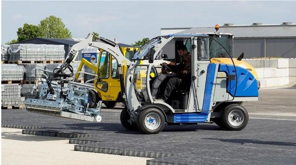
Bild 9: Verlegemaschine mit doppelter Knicklenkung [Foto: Probst]
