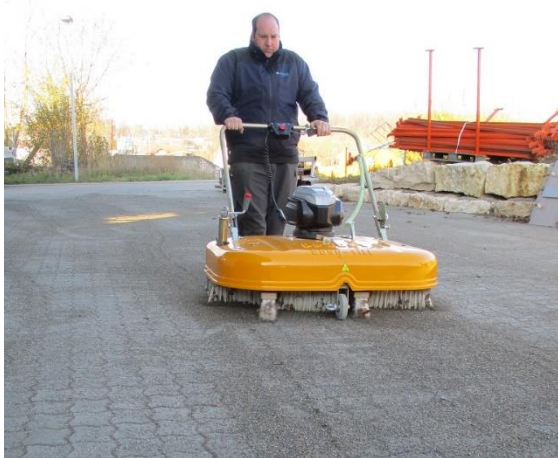
Bild 23: Maschinelles Einfegen von Fugenmaterial bei einer Pflasterdecke [Foto: Probst]
