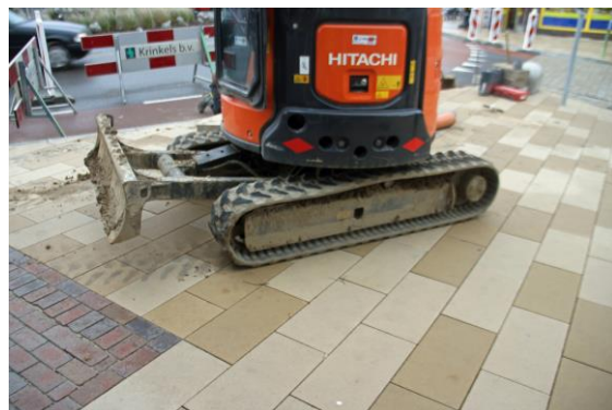
Bild 12: Gefahr von Pflasterverschiebungen durch Kettenfahrzeug auf nicht geschützter Pflasterdecke [Foto: Karl-Uwe Voß]
