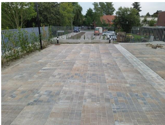
Bild 3: Die maschinelle Verlegung von nuancierten Pflastersteinen kann zu einem optisch unbefriedigenden Ergebnis führen [Foto: Pascal Präscheke]
