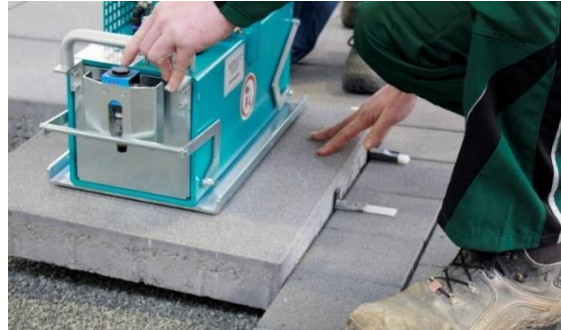
Bild 1: Beispiel für die Verwendung von Fugenlehren bei der Vakuumverlegung [Foto: Uwe Sehrt]
