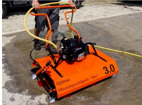
Bild 24: Maschinelles Einschlämmen von Fugenmaterial bei einer Pflasterdecke [Foto: Optimas]
