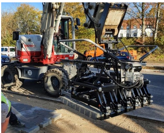
Bild 14: Maschinelle Verlegung von Pflastersteinen für einen Gehweg. Das Trägergerät (Bagger) befindet sich außerhalb der Fläche [Foto: Optimas]
