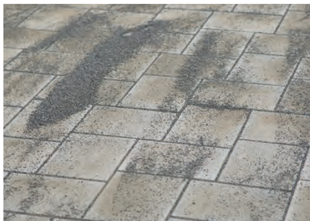
Verfüllen mit ENVIRO CLEAN Fugensubstrat
