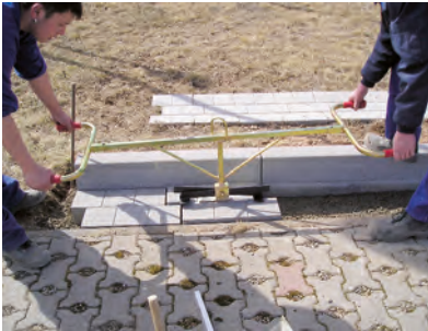
Modifizierte Bordsteinzange für hohe Versetzleistung mit 2-zeiligen Water-Line Pultrinnen.
