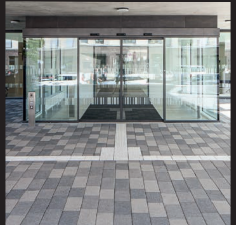
Belebende Flächen- wirkung mit City Truck Pflaster in den Oberflä- chen Hellgrau, Mittel- grau und Dunkelgrau
