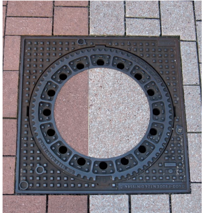
2-farbig ausbetonierter Schachtdeckel, Oberflächen geschliffen
