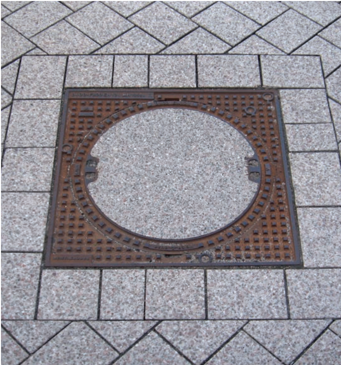
Ausbetonierter Schachtdeckel, Oberfläche geschliffen + glanzgestrahlt
