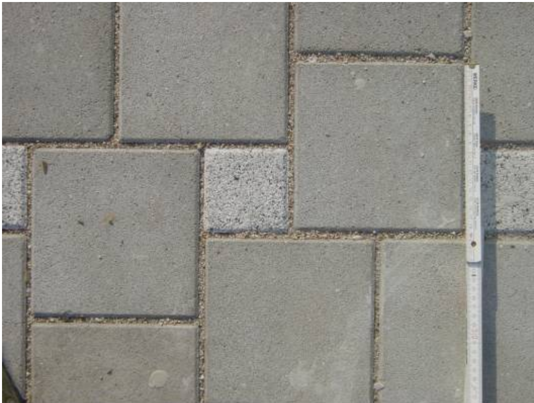
Bild 1: Pflastersystem Pasero Fuge 6,5 mm im Chemnitzer Verband
