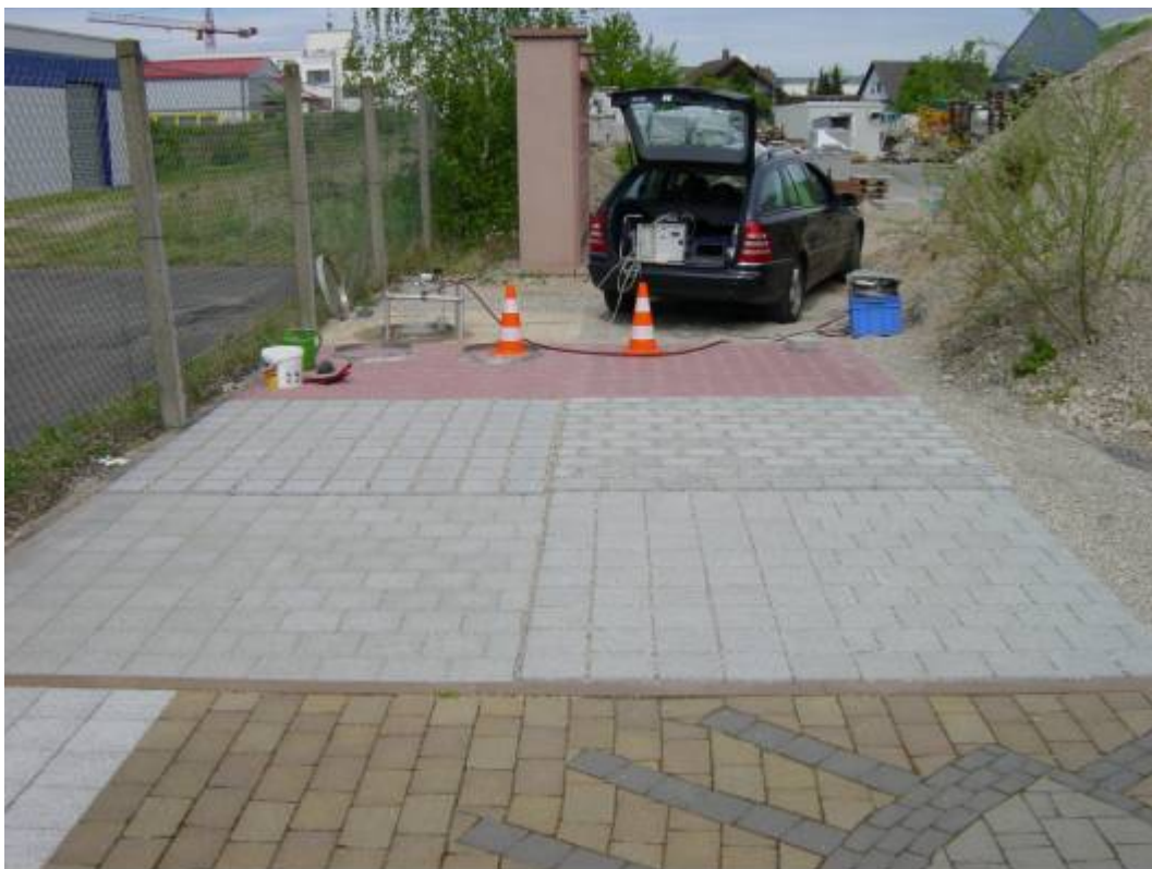
Bild 1: Pflastersystem Pasero Fuge 6,5 mm im Altdeutschen Verband
